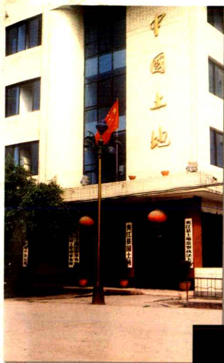
夹江县国土局办公大楼
