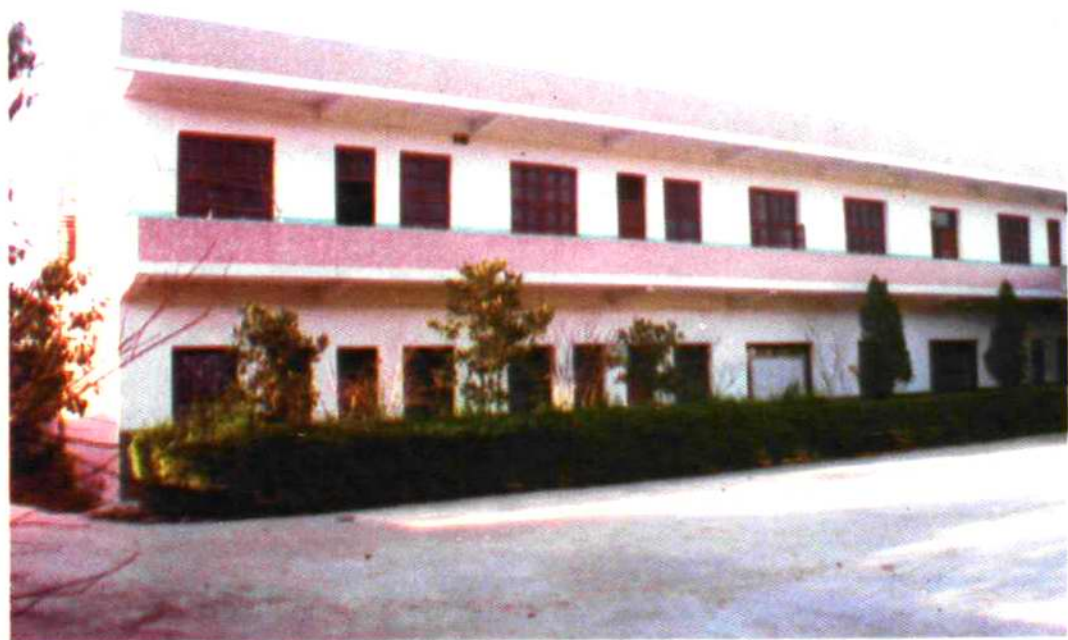
石城交管站办公楼
