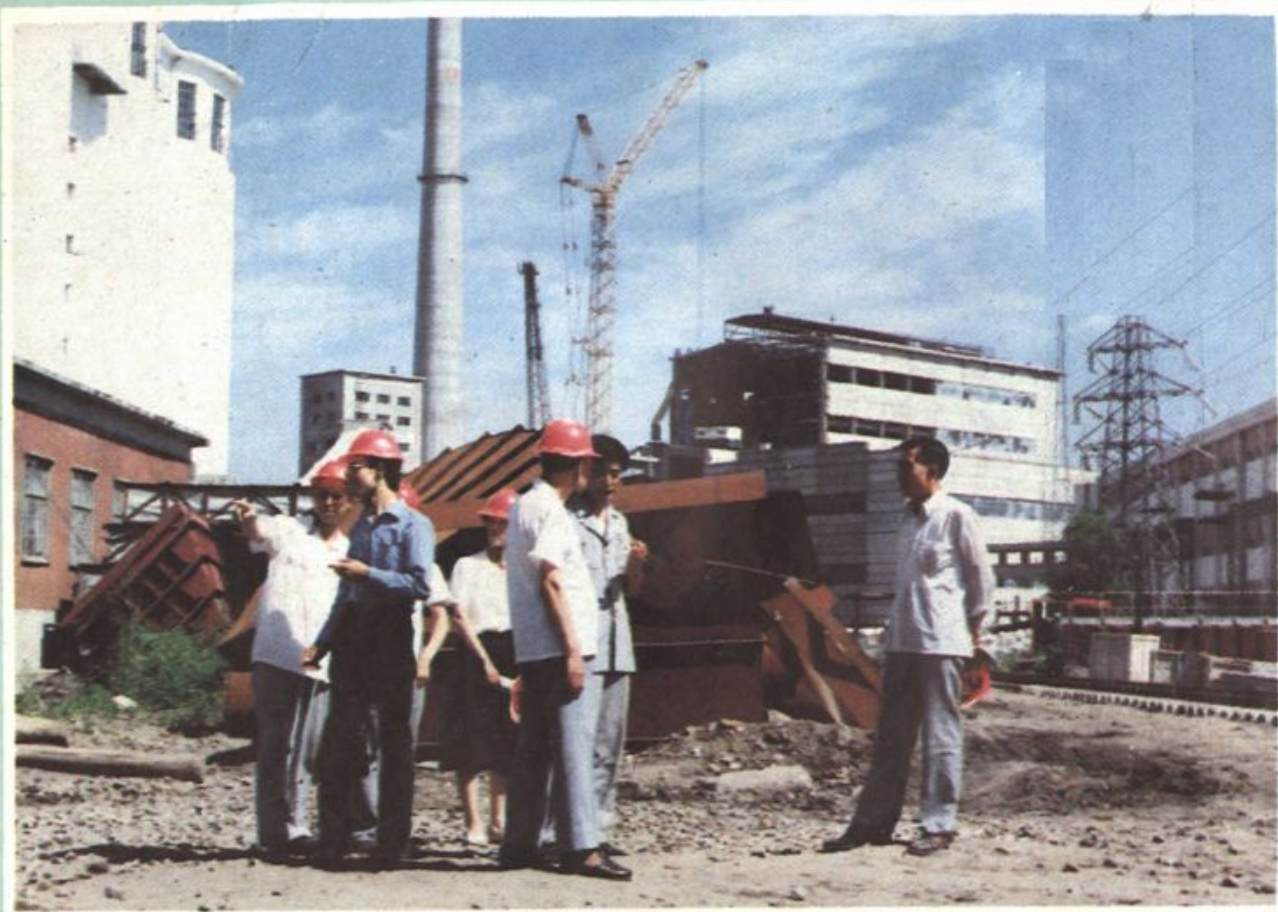
建设银行拨、贷款人员在建设项目施工现场检查资金使用情况之一
