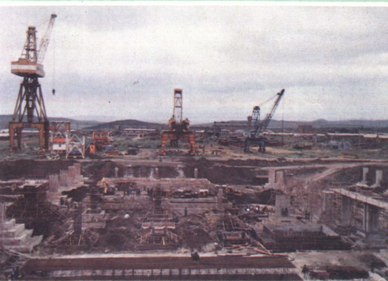
一九八五年开工建设的双鸭山发电厂工地
