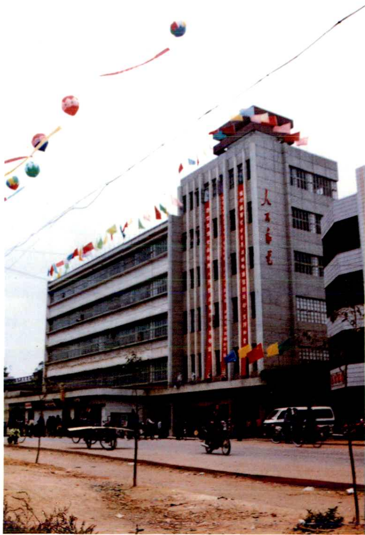
南康邮电生产综合大楼
