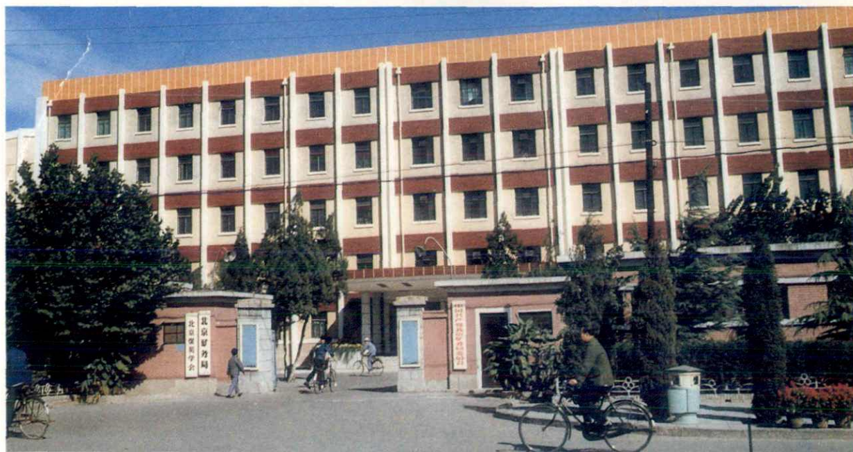
北京矿务局办公楼 ◇
