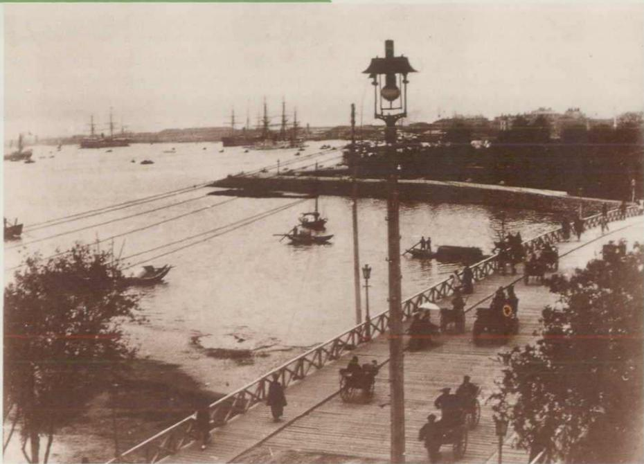
清光绪八年(1882年)华东第一座上海电气公司电厂在南京路江西路转角处建成投产,图为该电厂向外滩一带供电的电弧路灯
