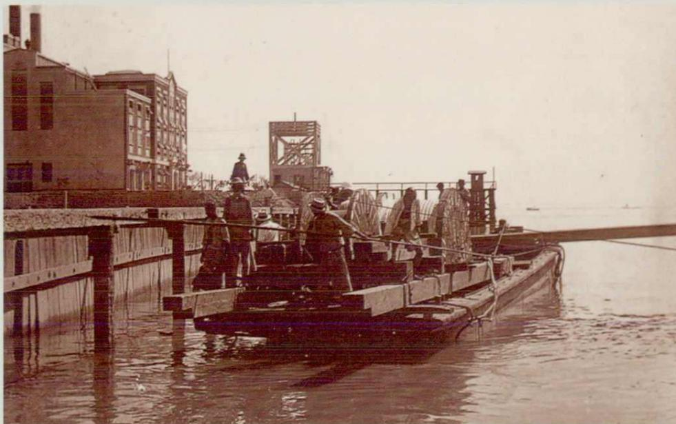
民国 22 年(1933 年)浙江杭州电气公司建设 13.2kV 闸(口)—萧(山)线路正在敷设跨越钱塘江水底电缆
