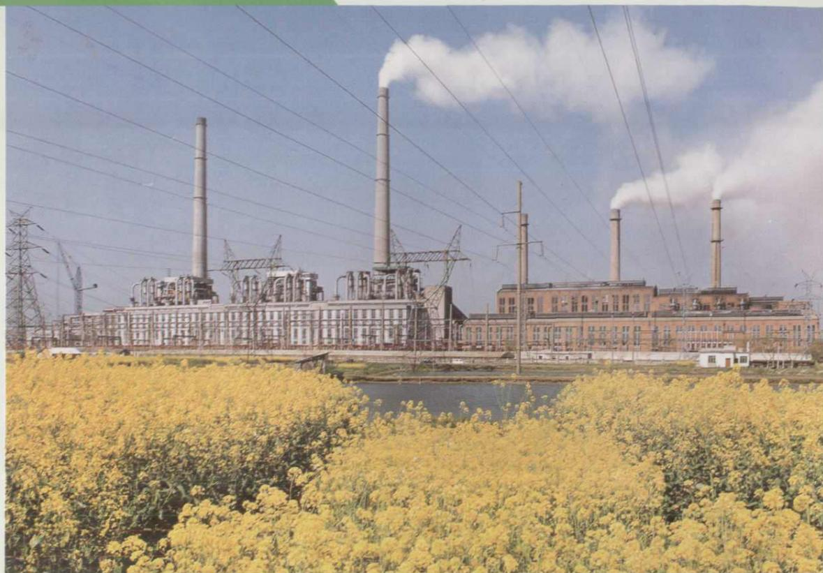
江苏谏壁发电厂装机容量 162.5 万 kW,为全国最大的火力发电厂
