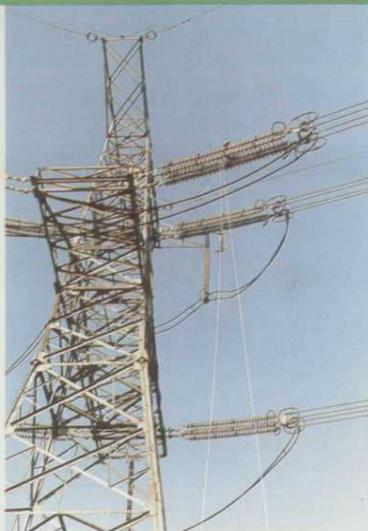
500kV 徐(州)—沪线路铁塔上将张力导线挂上绝缘子
