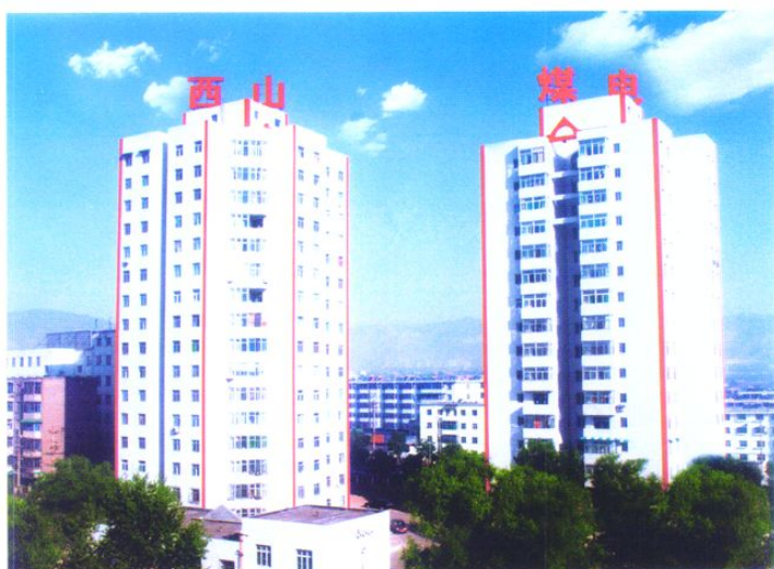
由我公司施工建设的西山地区第一座高层住宅楼
