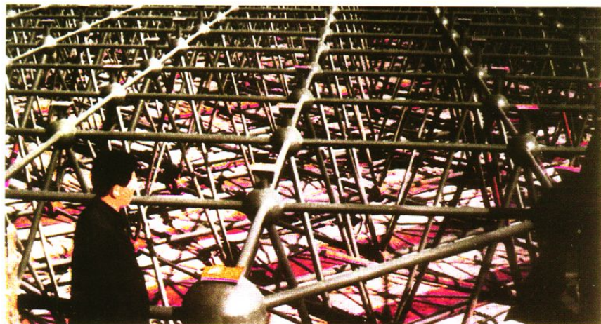
施工中的大型 网架结构工程
