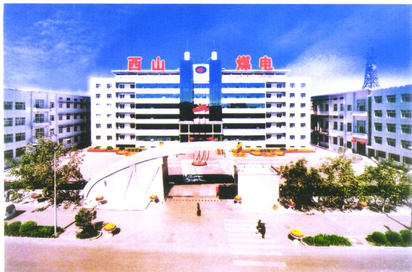
由我公司施工建设的集团公司办公楼
