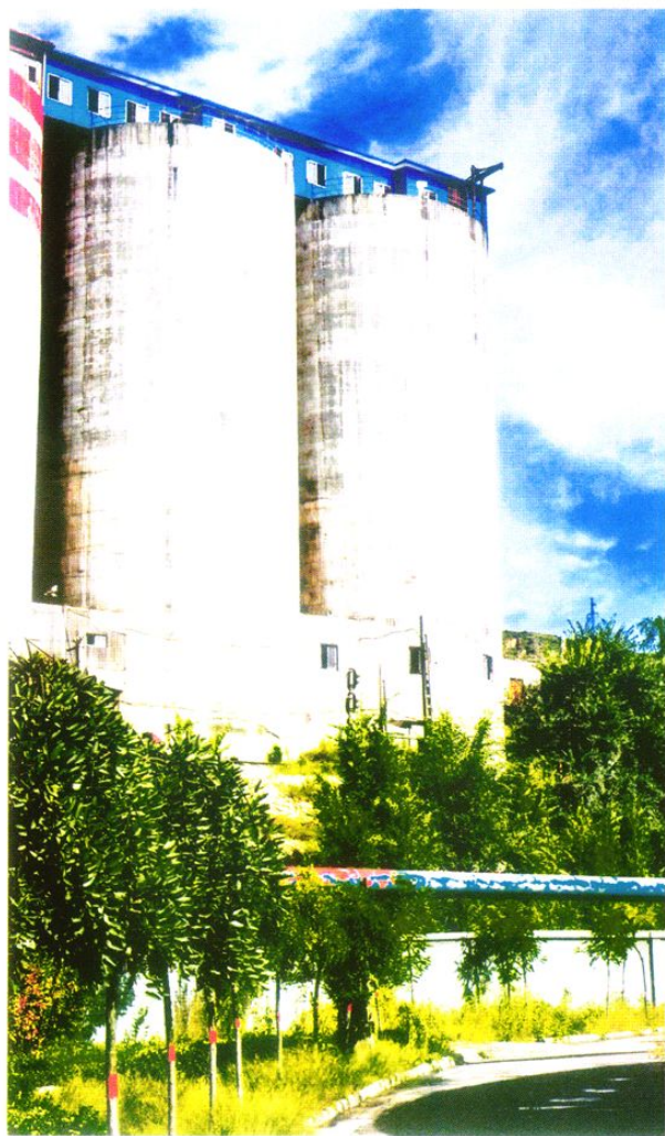
由我公司施工建设的马兰精煤仓
