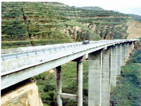
312国道彬县南沟大桥
