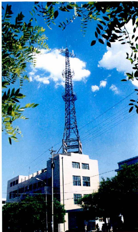
彬县邮电大楼
