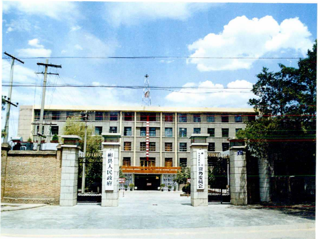
彬县人民政府办公大楼
