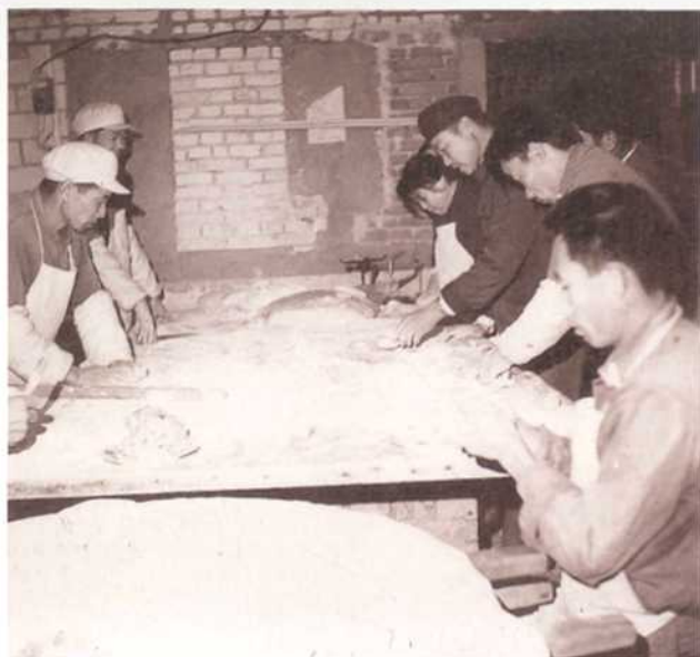
在焦炉工地工作的 建工处三队职工食堂炊 事班
