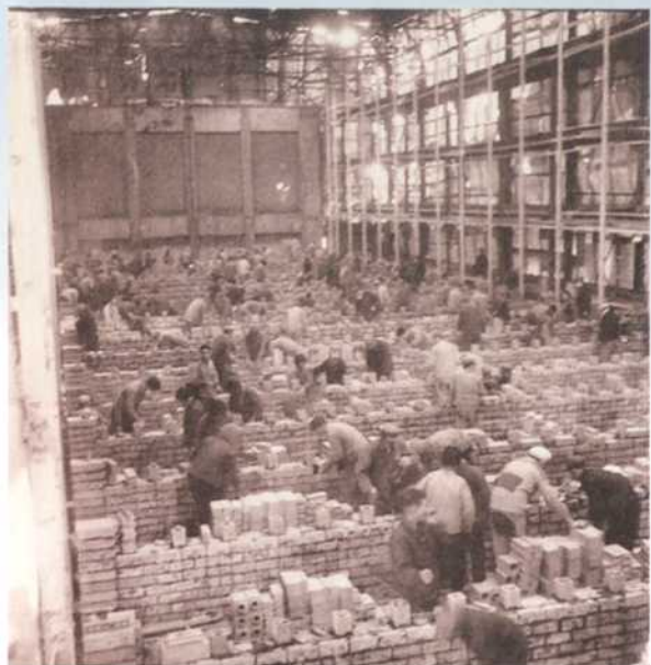
1975 年，建工处首次承建莱钢焦炉施工现场
