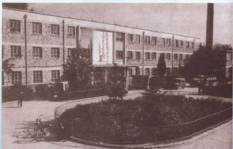
由工程团一连施工的莱钢医院，主体为“王”字型，全部石头砌成。于1972年建成投入使用
