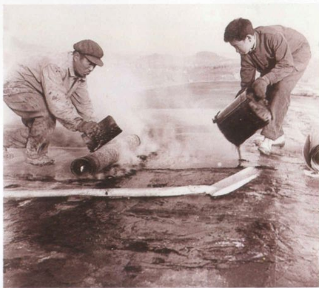
建工处承建的 锻压厂房屋面防 水处理工程
