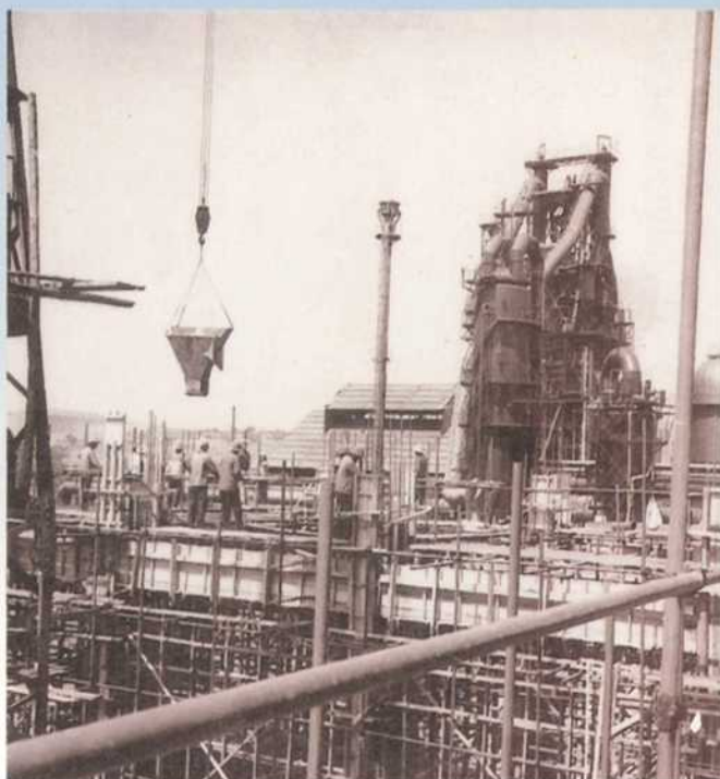
1975 年，施工中的 620 立方米高炉配套工程
