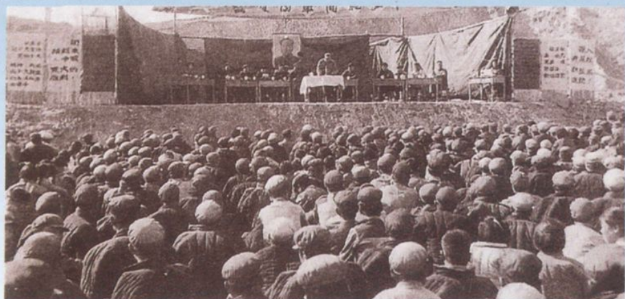
1973年11月，工程团作为一支建设大军参加莱钢轧钢厂七五〇初轧工程开工誓师大会
