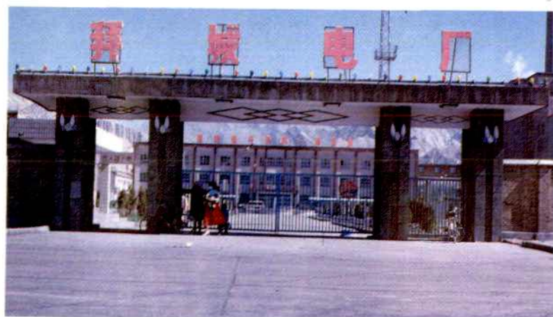
拜城电厂第二生产区
