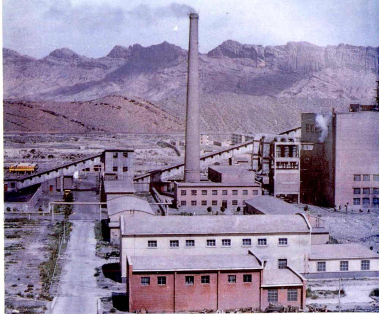
拜城电厂第二生产区一角
