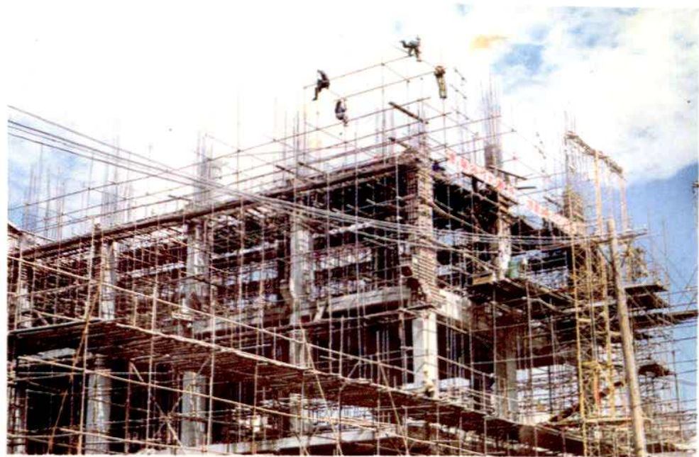
在建中的 2 \times 2.5 万千瓦机组汽机房
