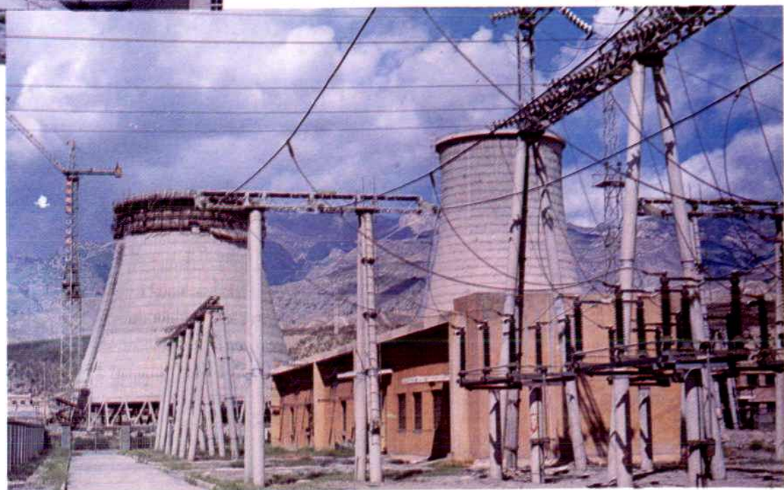
2× 2.5 万千瓦机组冷却塔正在施工中
