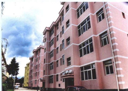
新建教职工宿舍之二（竣工于2011年）
