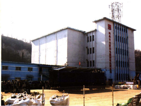
天元废旧电器回收处理车间
