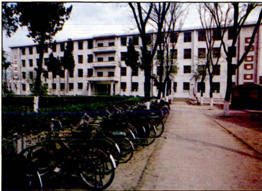
北关中学教学大楼
