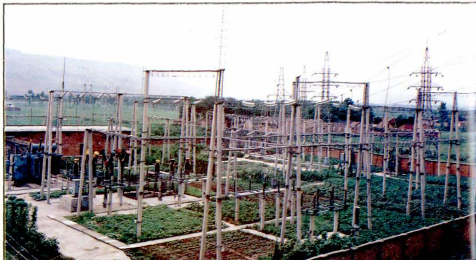
电力局变电所
