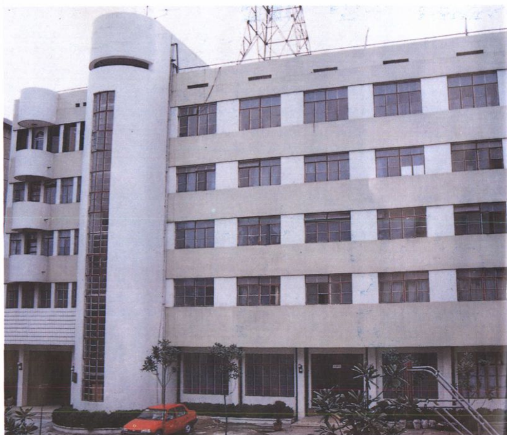
温州市工商行政管理干部学校教学楼
