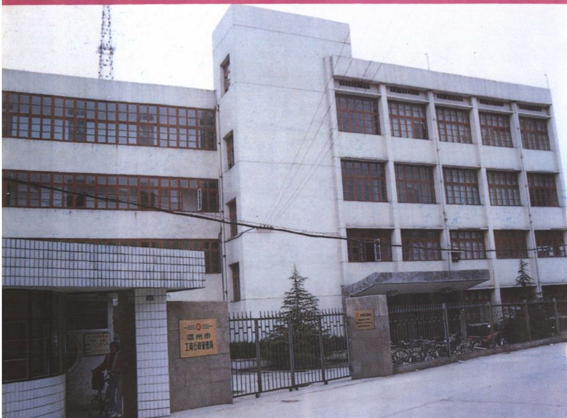
温州市工商行政管理局办公楼
