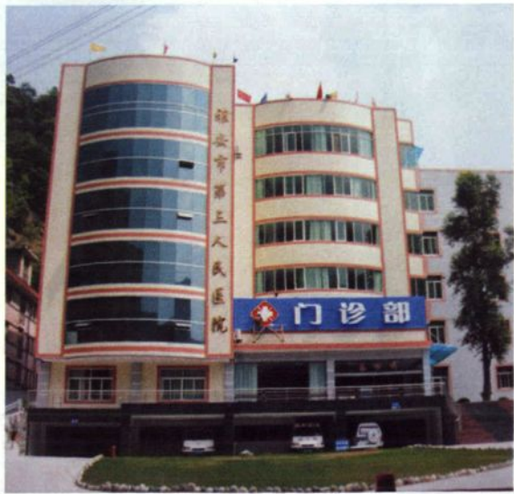
财政投资修建的雅安市第三人民医院门诊大楼
