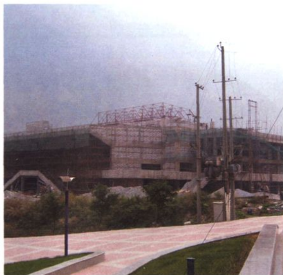
财政投资，正在修建中的石棉县体育馆
