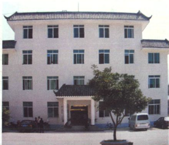
安顺彝族乡办公大楼
