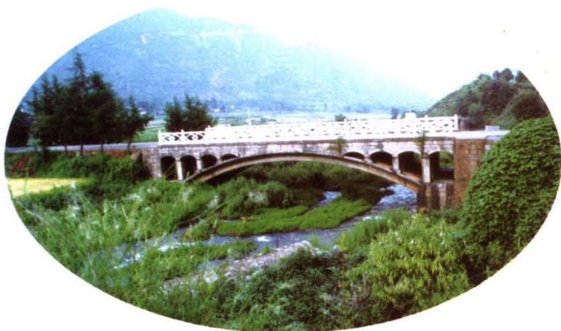
◀ 盒子孔公路桥
