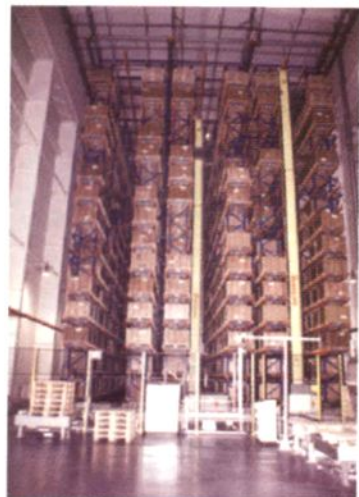
常德卷烟厂高架库
