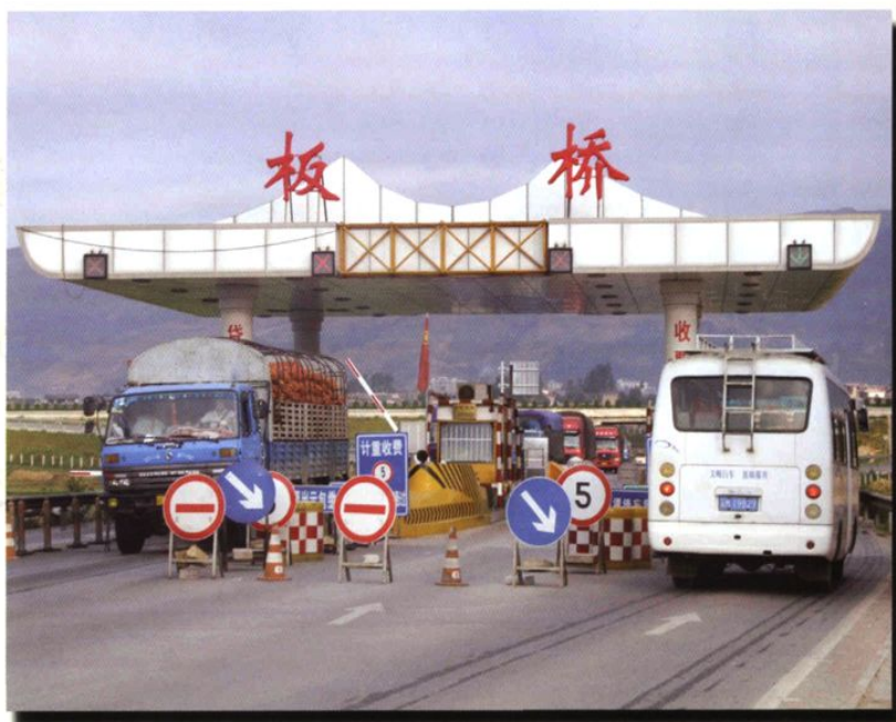
辖区内的 大保高速公路板桥收费站
