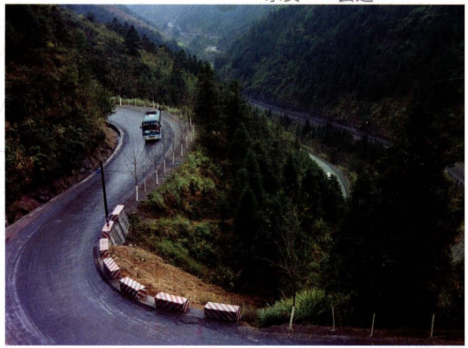
207 国道双牌大山公路
