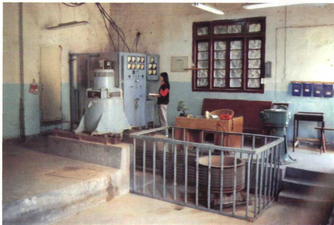
遂昌龙潭水电站,建于民国 35 年(1946 年)
