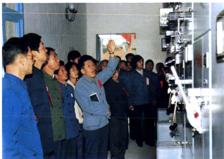
110 千伏紧水滩至龙泉输变电工程启动现场
