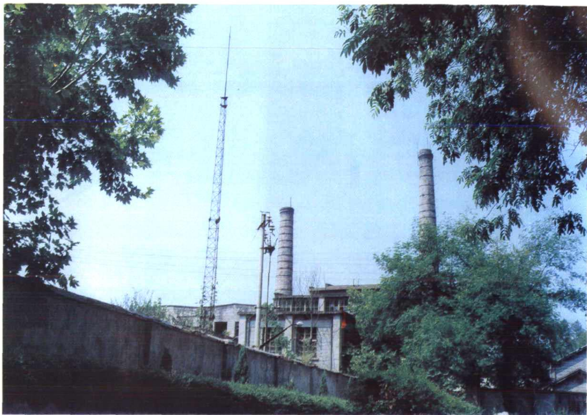
丽水市桃山火电厂,装机容量 4000 千瓦
