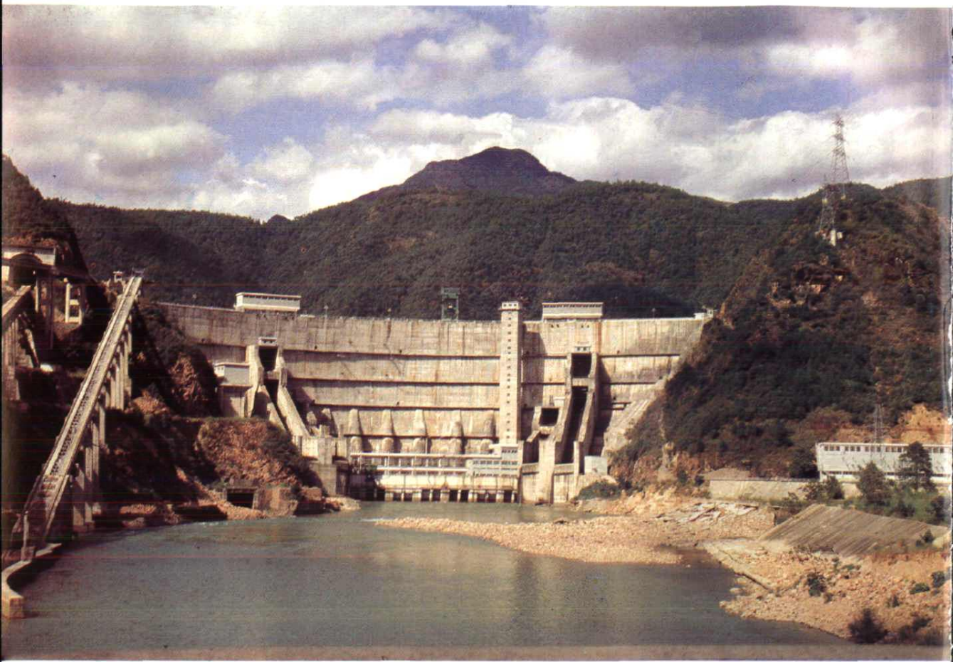
紧水滩电站,6台机组,共装机容量 30 万千瓦
