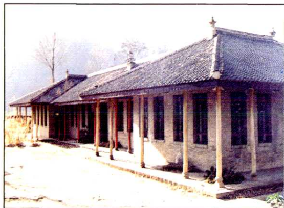
陕甘宁边区关中分区 1942 年修建的马栏工字房礼堂
