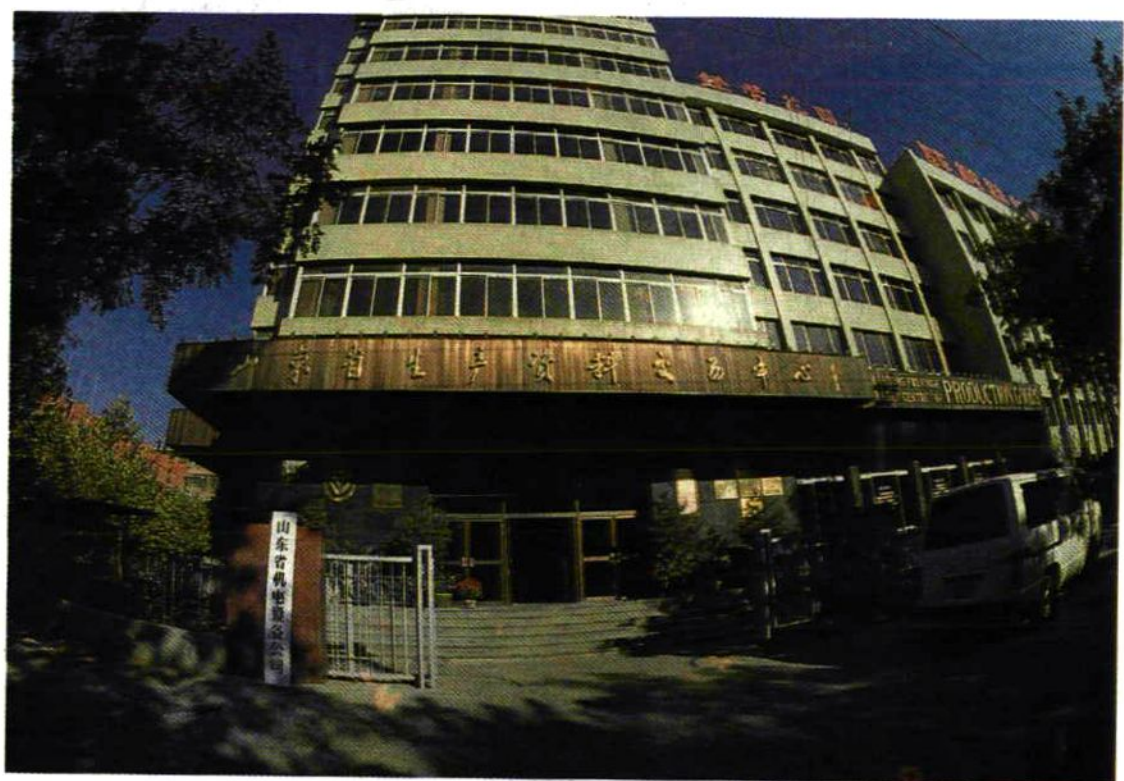
山东省机电设备公司办公大楼
