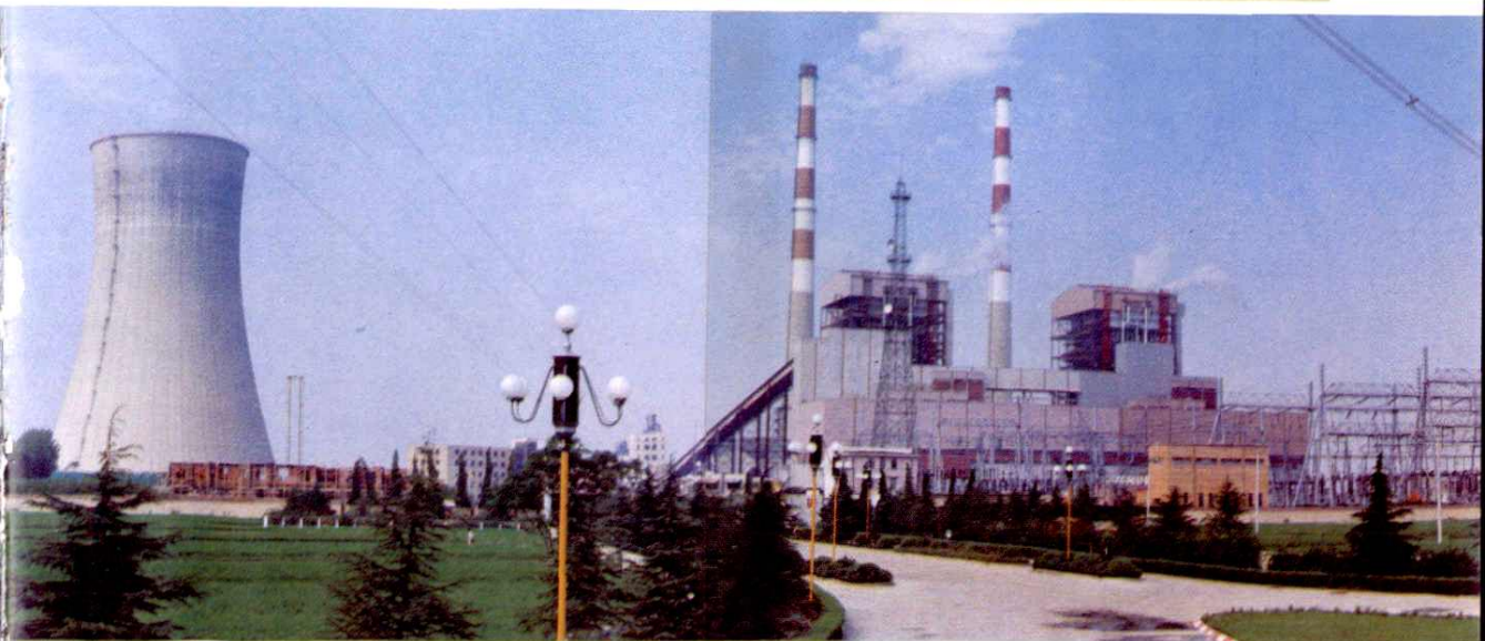
安徽电建二公司承建的国产 2 \times 60 万千瓦发电机组——平圩发电厂竣工投产后的全貌
