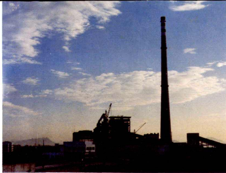
公司承建的浙江温州发电厂扩建工程
