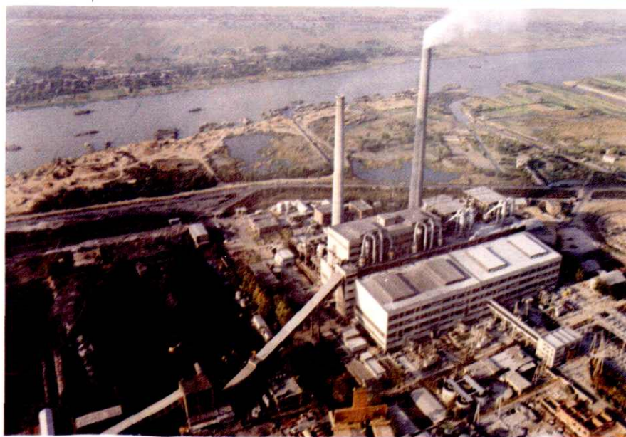
图为安徽淮南田家庵电厂 技改工程
