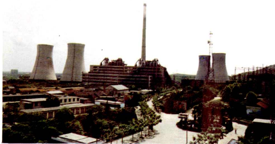
由安徽电建二公司承建的 淮北发电厂
