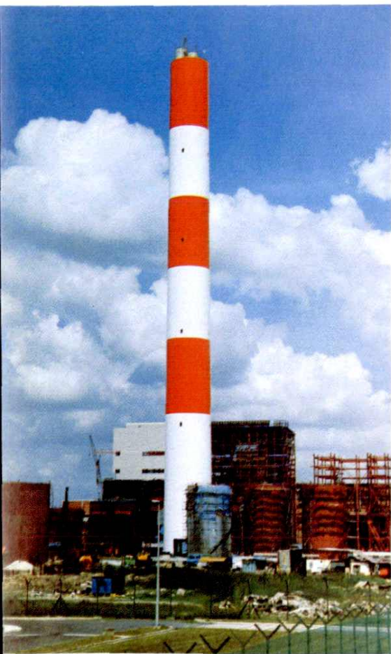
公司承建的新加坡西拉雅烟囱工程
