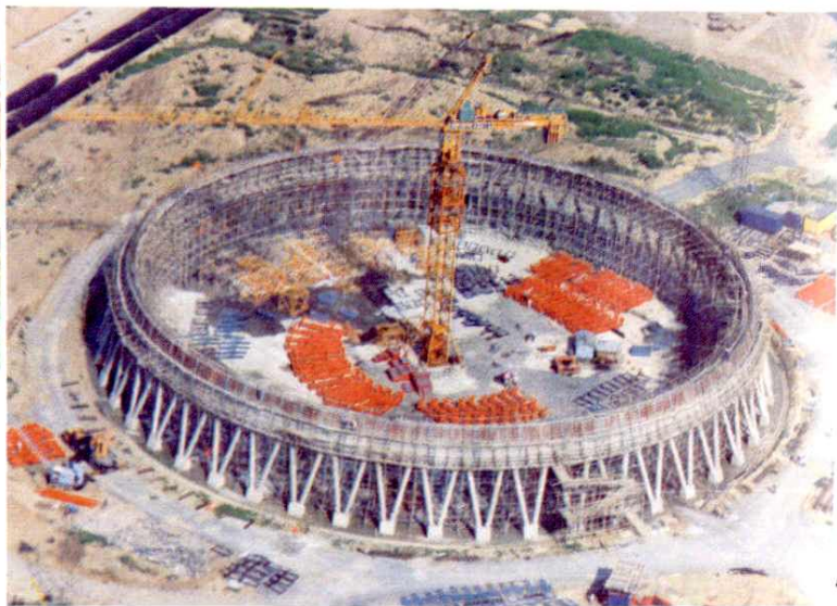
平圩电厂6300平方米冷却塔工程。 图为滑模施工现场
