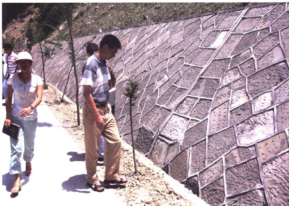
副局长何斌芳(右一)检查公路沿线的防护设施
