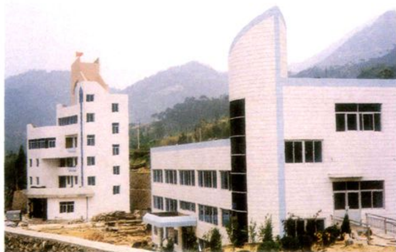
长白桥水电站厂房和办公楼
