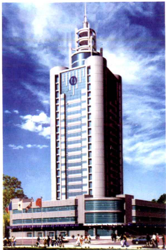
第一高层建筑—通信大楼
