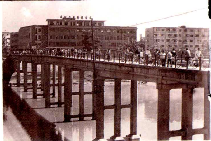
周口大桥（1935年建）
