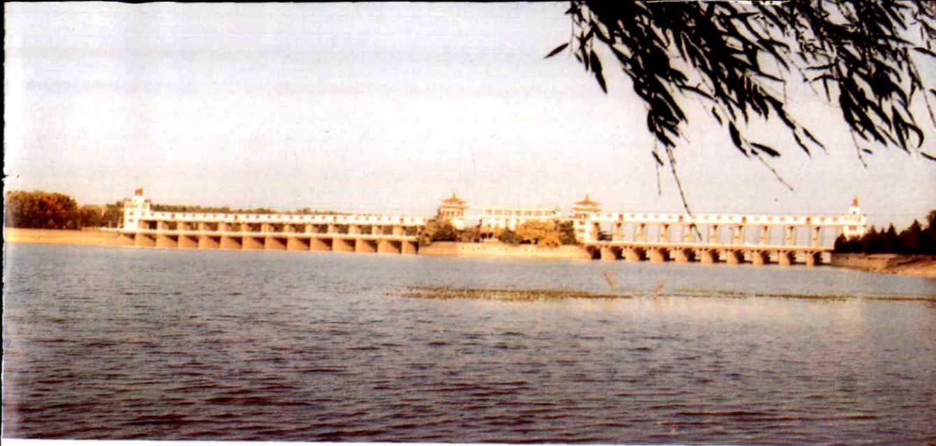
周口水利枢纽工程拦河闸
