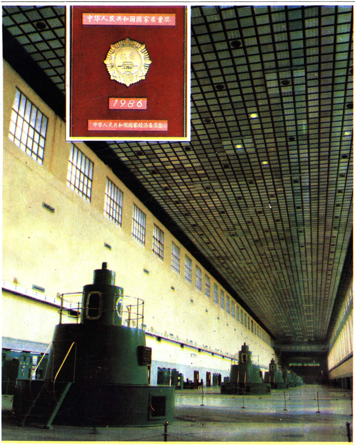
▲ 哈尔滨电机厂研制的“12.5万千瓦水轮发电机组”安装在葛洲坝电站,获1985年国家科技进步特等奖和金质奖章。
