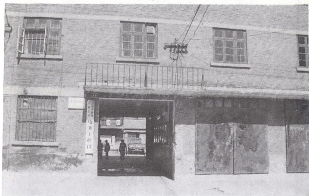
电务工程公司(段)办公楼
