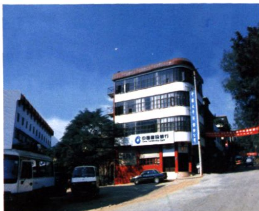
支行原兴隆街储蓄所
