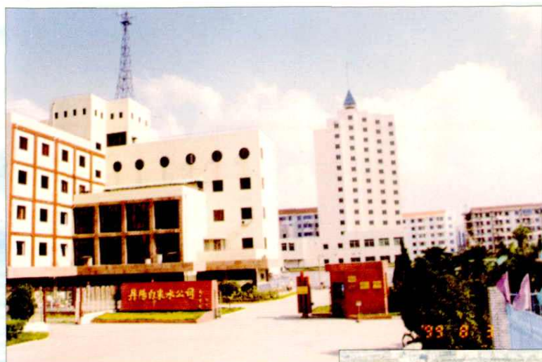
丹阳自来水公司综合楼
