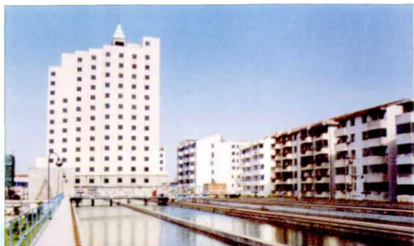
丹阳自来水公司供水三厂改造 后的平流沉淀池
