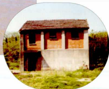
建于1964年的供水 一厂快滤池外貌
