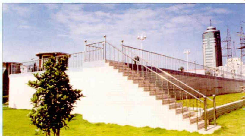
丹阳自来水公司供水 三厂新建的50000立 方米/日快滤池
