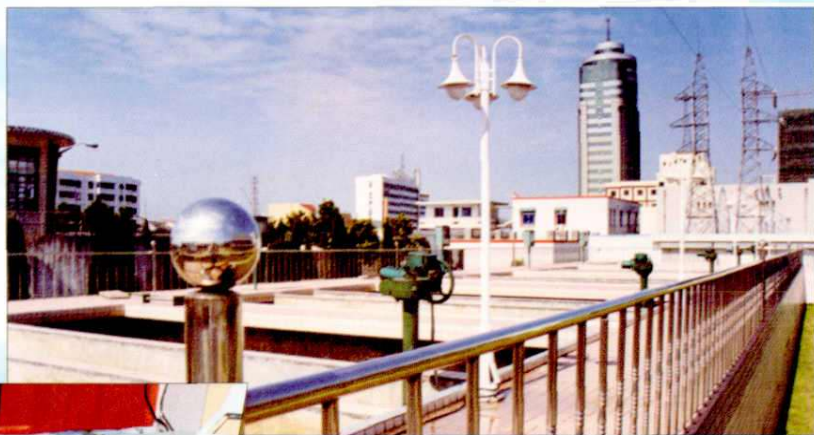
丹阳自来水公司供水三厂
