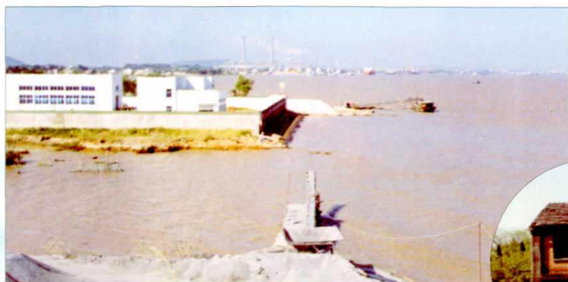
丹阳市长江取水工程江边源水厂
