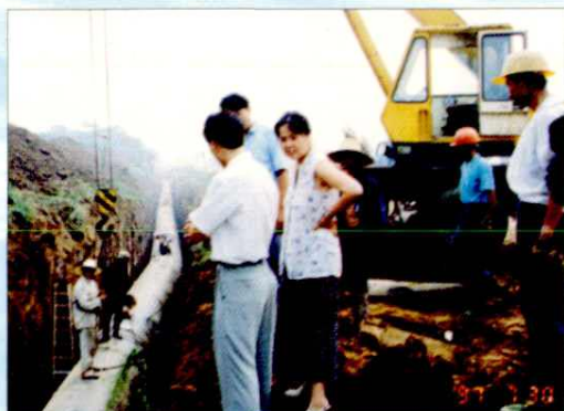
长江取水工程管道安装施工现场
