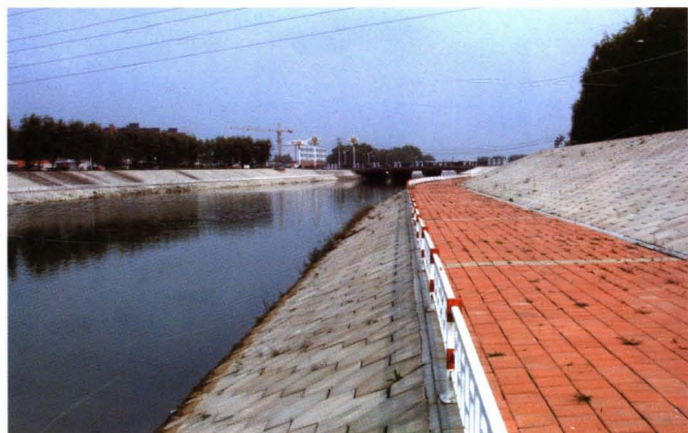
石溪河城市防洪工程
