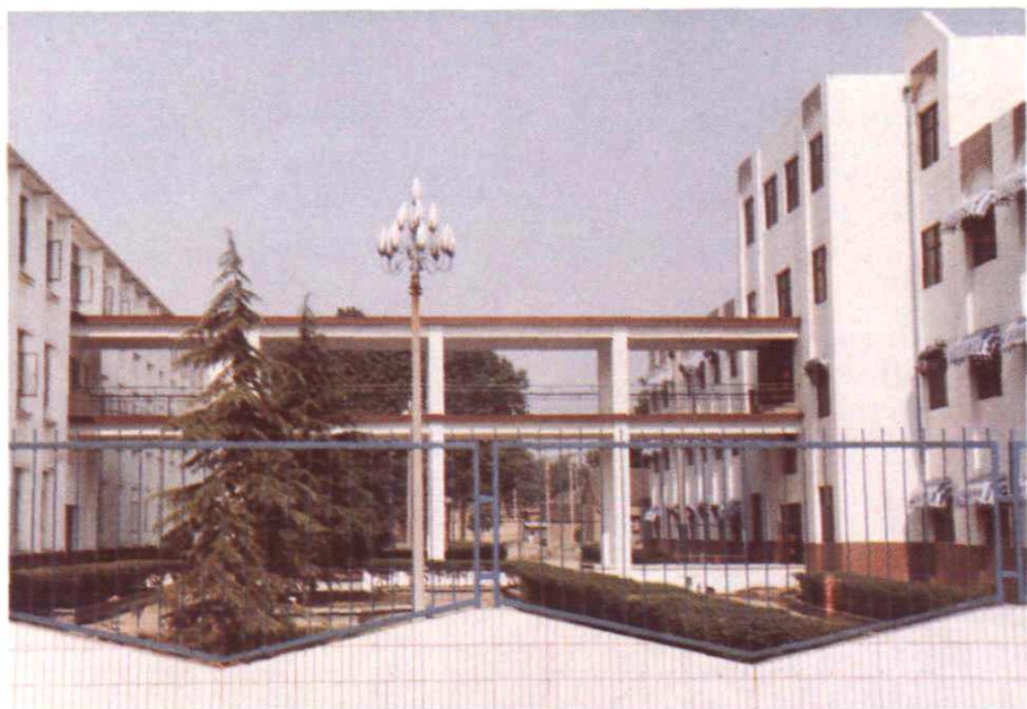
连接办公楼与教学楼的天桥
