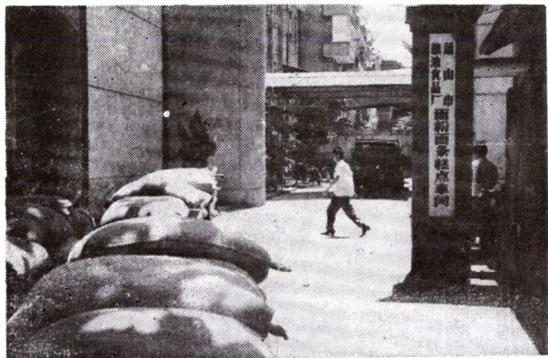
现有面粉、面条、食品、机修车间大门
