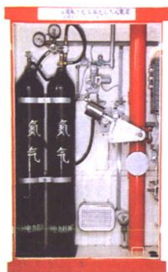
消防櫃 Fire Extinguishing Cubicle
