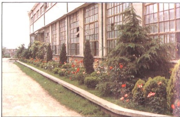
管道支吊架车间外景
