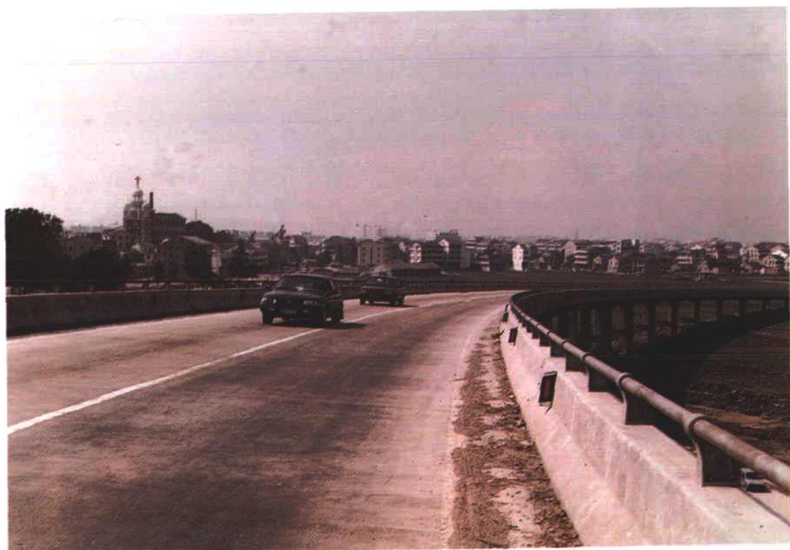
104国道线瓯北段高架桥
