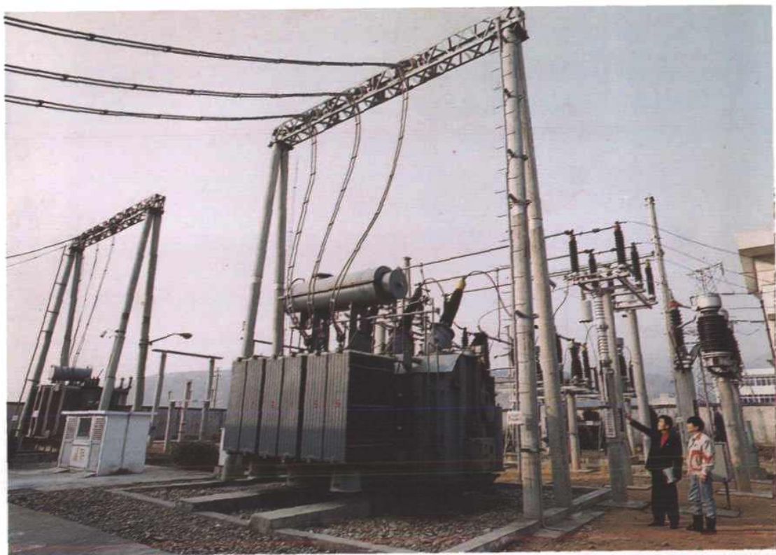
瓯北变电所11万伏变压工程
