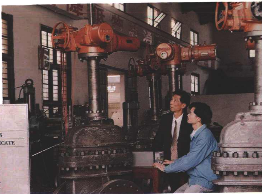
浙江保一阀门集团(有限)公司调试车间
