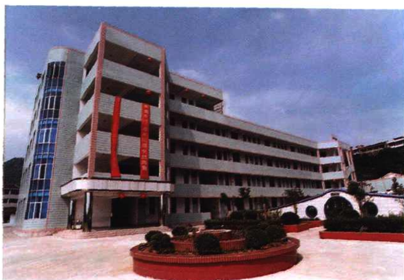
瓯北镇第一小学教学楼
