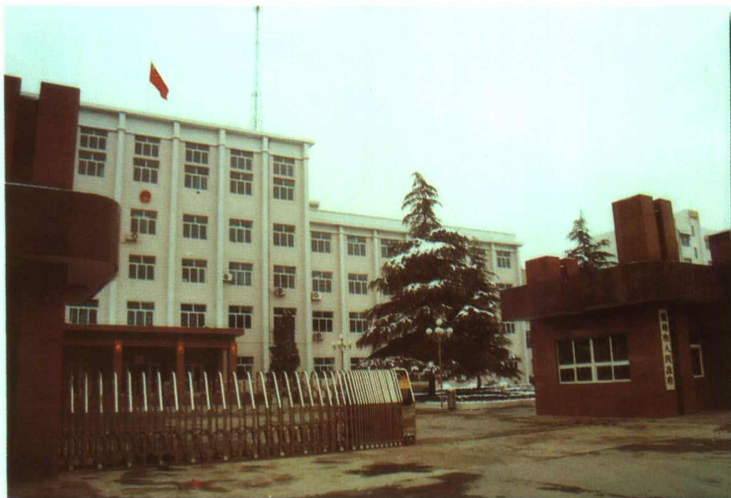
市政府办公大楼
