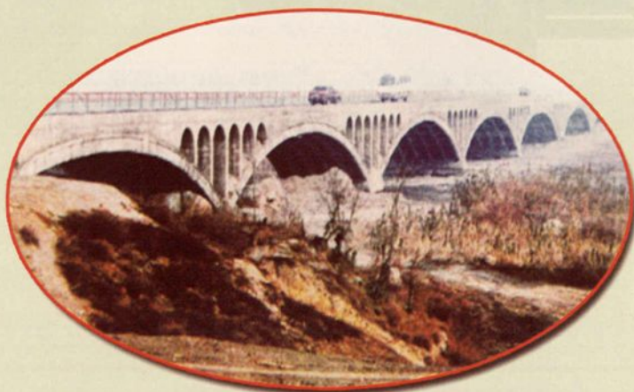
南门湫水河大桥
