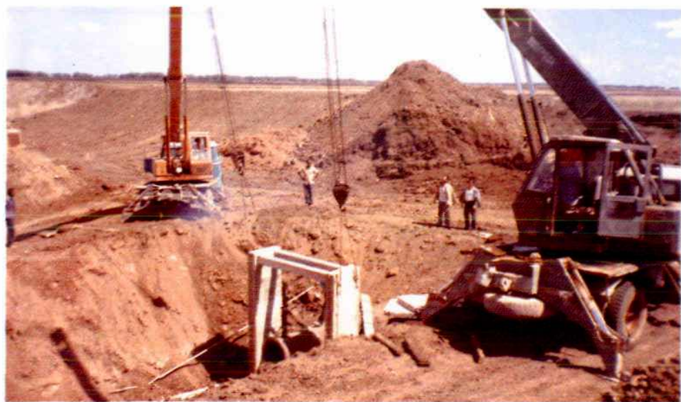
中国政府援 建的索马里费诺 力农场水利工程 施工现场
