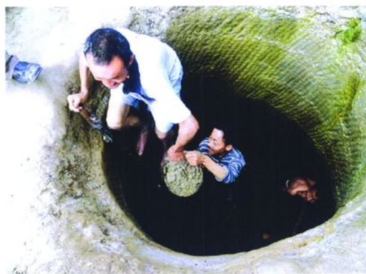
农民正在打水井
