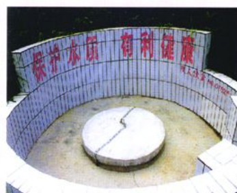
人饮工程—集中供水站
