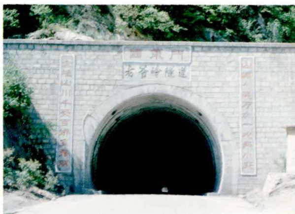
华金公路老爷岭隧道
