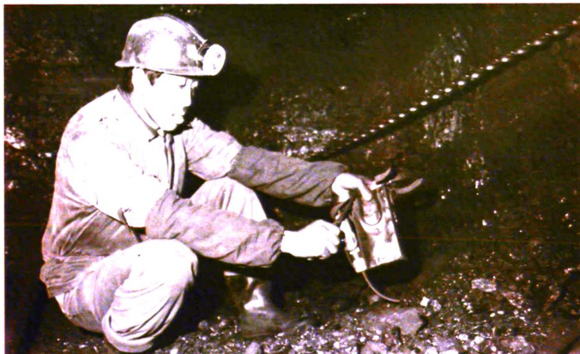
瓦斯检查员在采煤掌子面进行瓦斯检查
