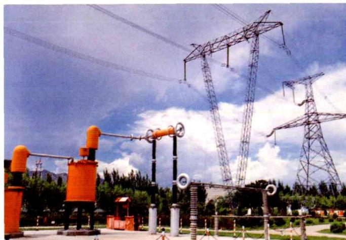
500 千伏超高压带电作业培训模拟线路
