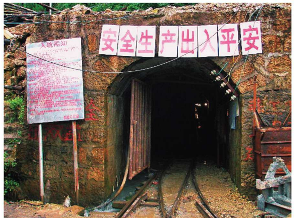
瑞土公司柴家营矿区 10# 洞采矿坑道
