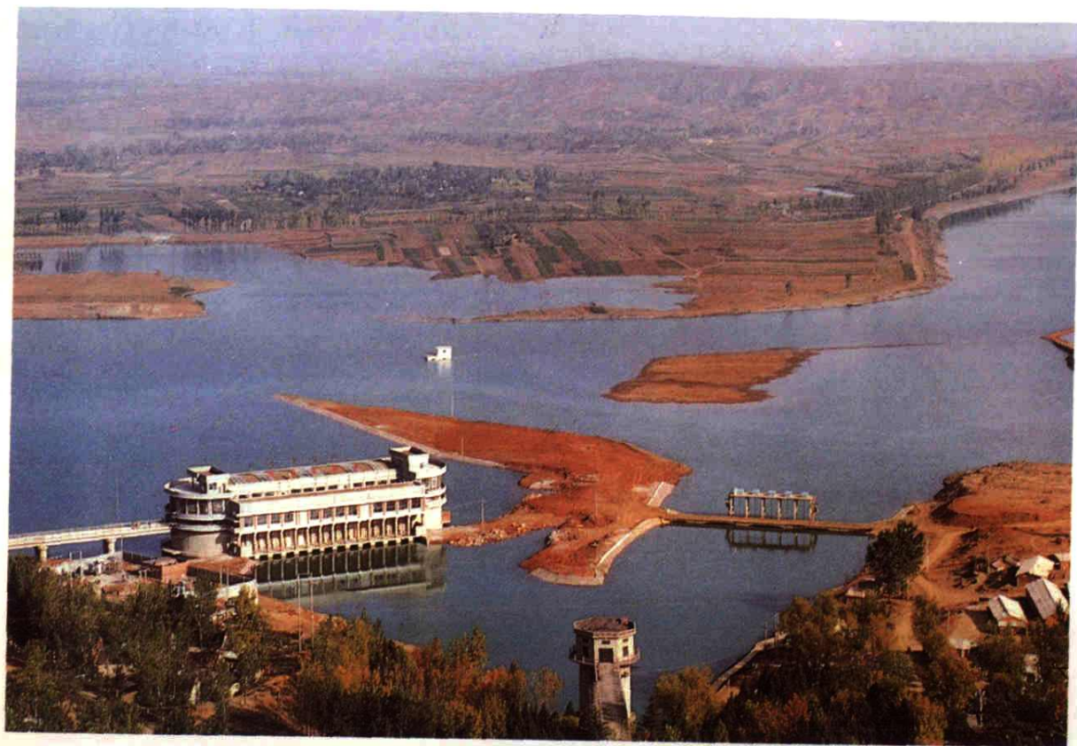
清泉沟灌溉泵站
