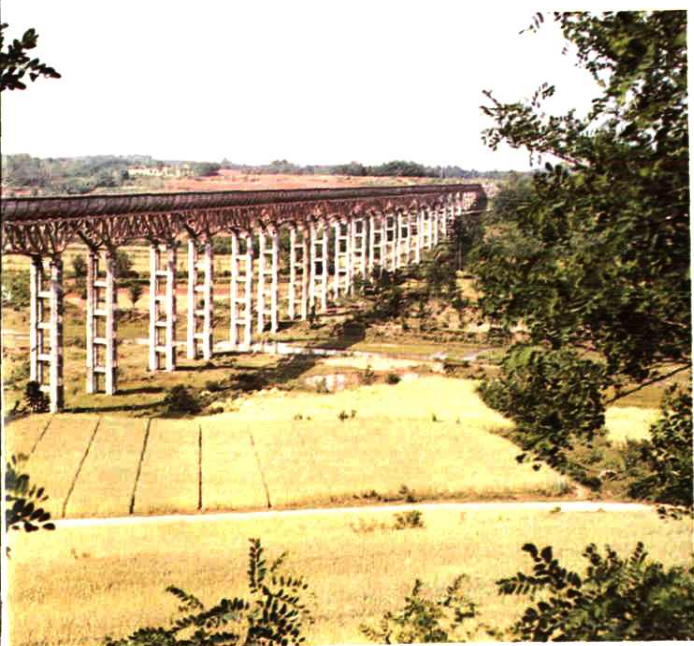
漳河·永盛渡槽
