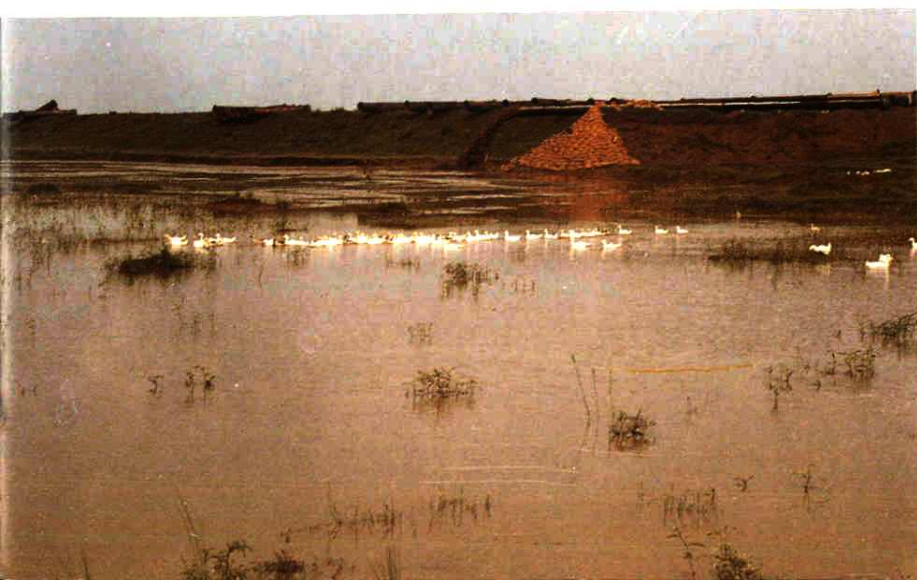
吹填荆江大堤铺盖
