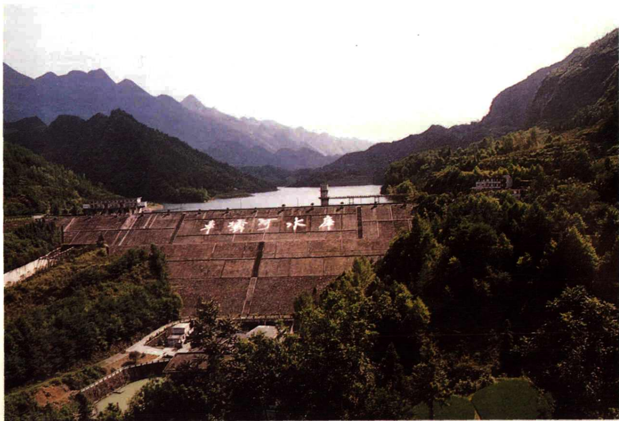
车坝河·沥清面板坝
