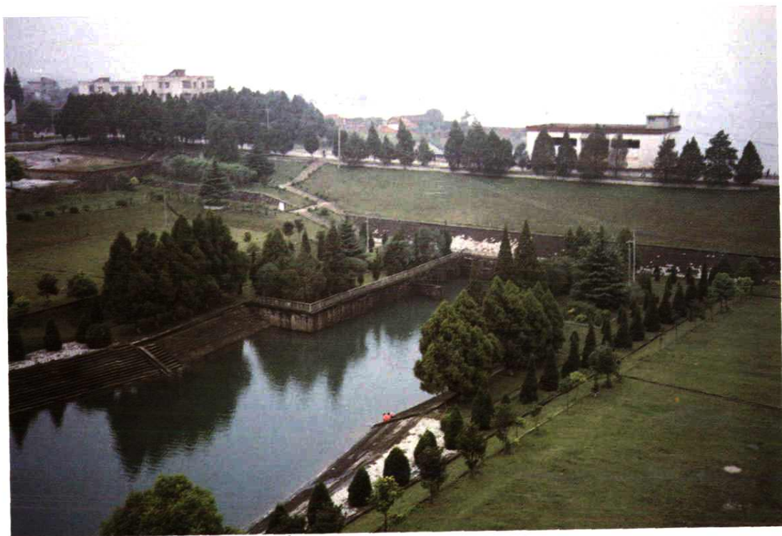
漳河·烟灯闸·总干渠
