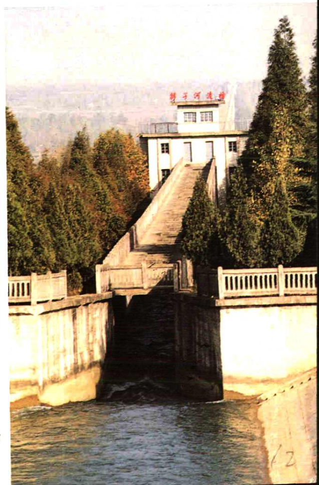
引丹灌区排子河渡槽
