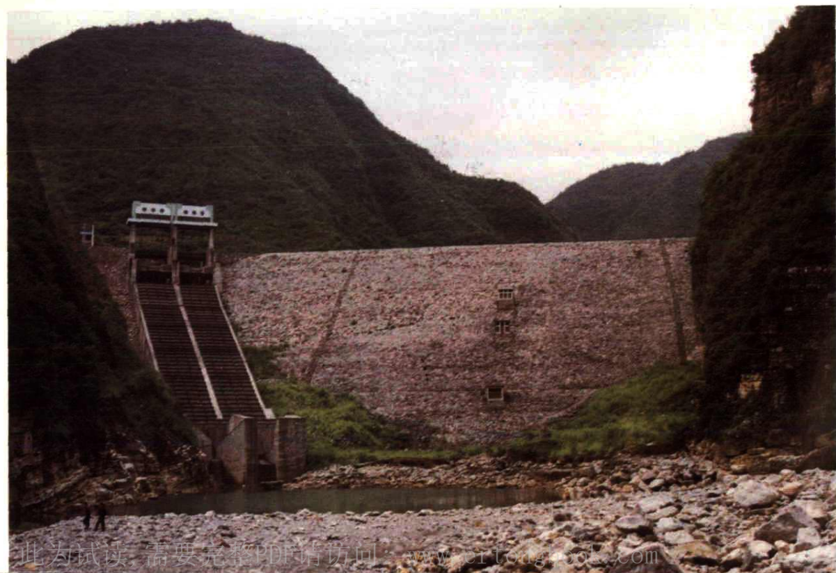
西北口·混凝土面板坝
