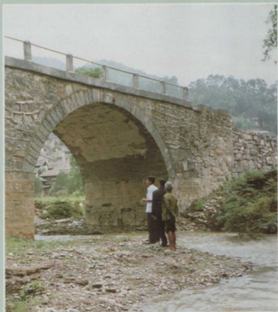
▼境内跨径大、桥体长的八嘎嘎那桥
