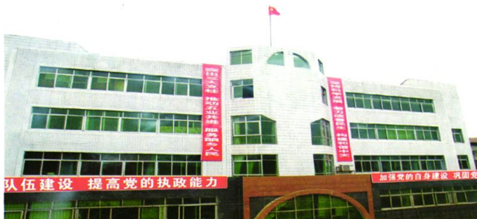
中天镇党委、人大、政府办公大楼（1998年建造）
