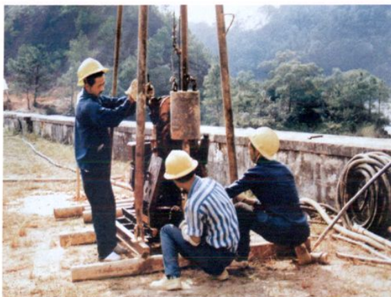
◎ 水库除险加固应用劈裂灌浆技术。
