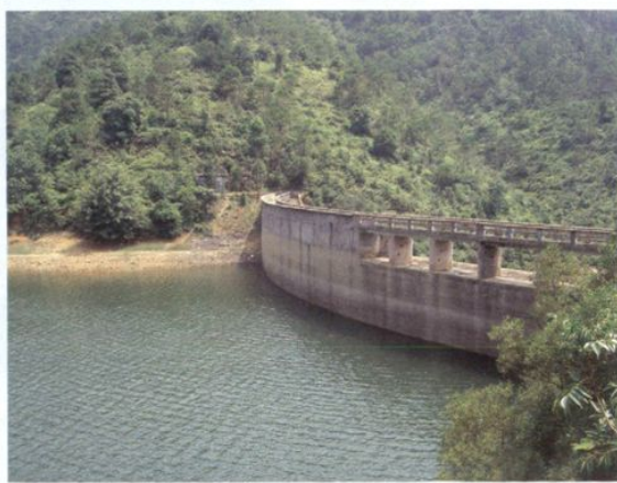
◎ 鹤山龙潭水库拱坝。
