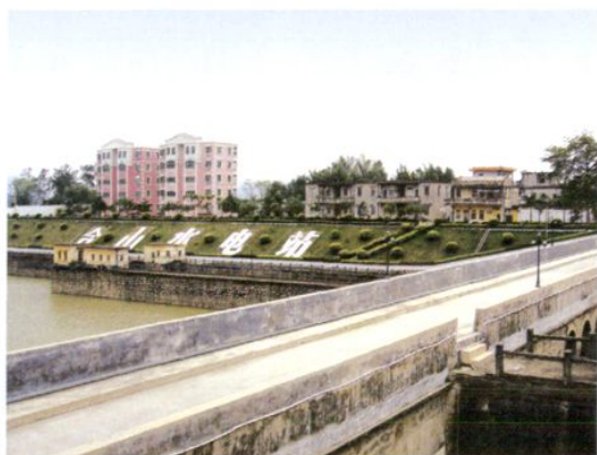
◎ 江门市台山水利枢纽工程。
