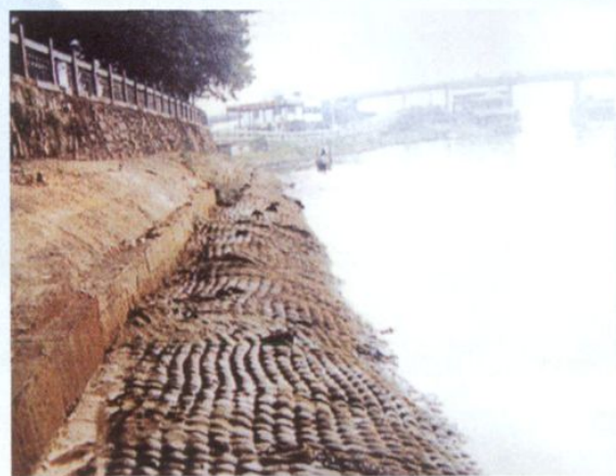
◎ 织物模袋混凝土护岸技术在江新联围险段的应用。
