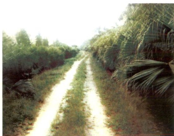
◎ 加固前的江新联围外海堤段。
