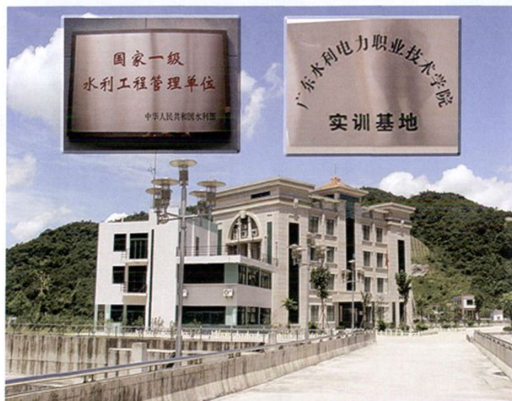
◎ 江门市锦江水库工程管理处。
