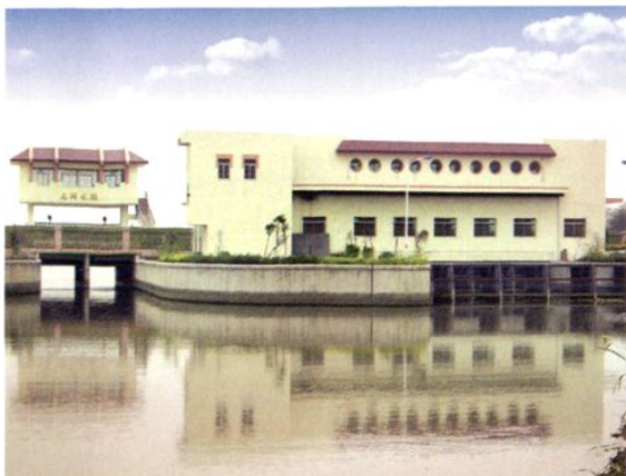
◎ 江海区石洲水闸及电排站。
