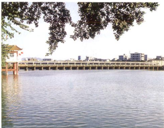
◎ 恩平市恩城水闸。
