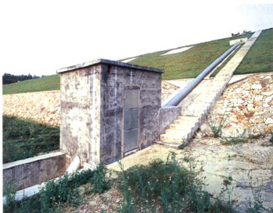
◎ 虹吸式输水涵管在水库的应用。
