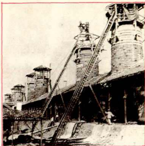
▲ 洪家洲炼铁小高炉群 (1958 年)
