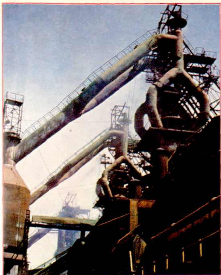
▲ 涟源钢铁厂 300m 3 炼铁高炉
