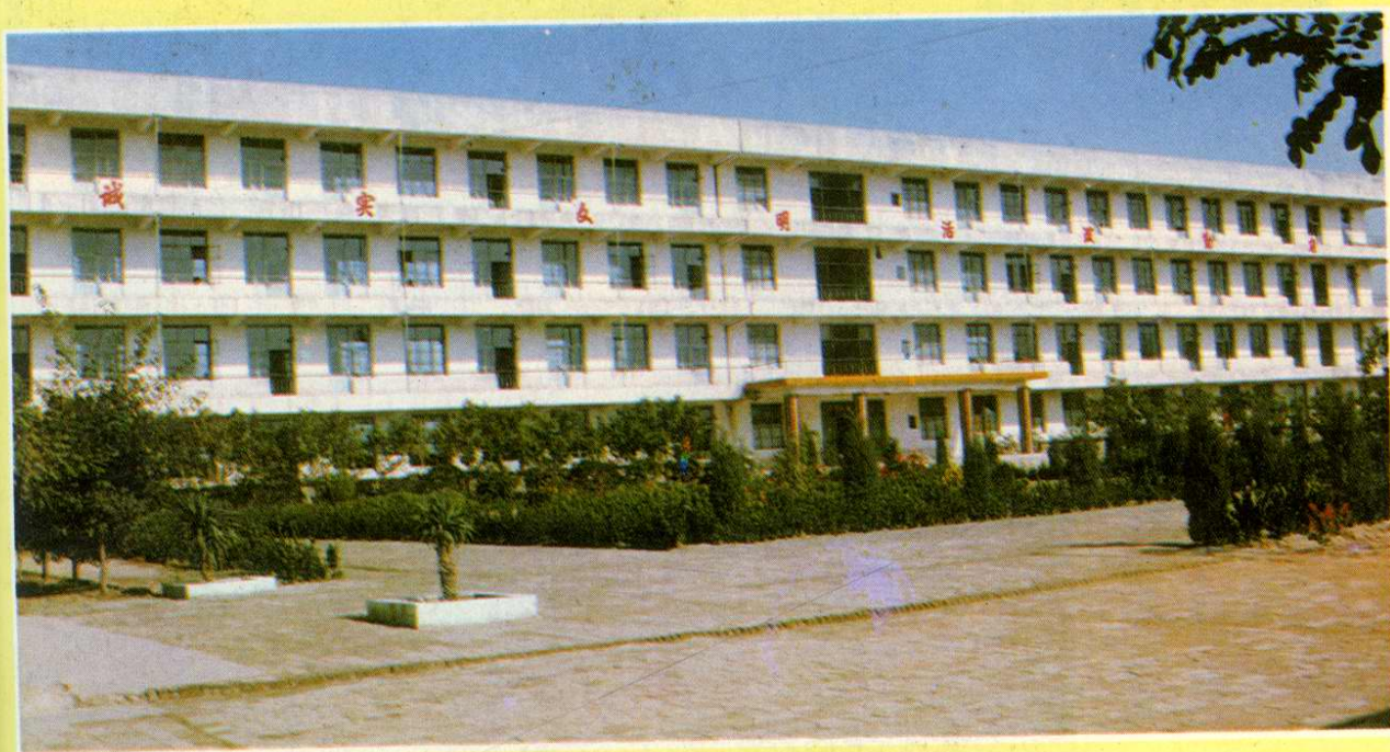
▲ 城关镇初级中学教学大楼
