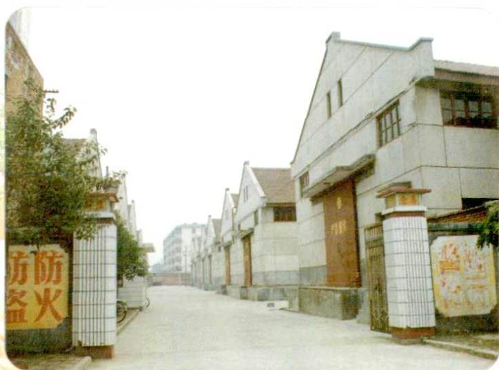
四组仓储库房
